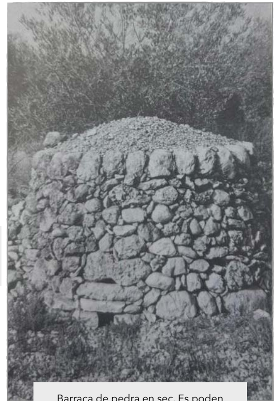
Barraca de pedra en sec. Es poden observar els dos forats: el superior (l'espitllera), per a la guaita vigilant, i l'inferior, per a fer passar la corda que permet estirar el filat.
